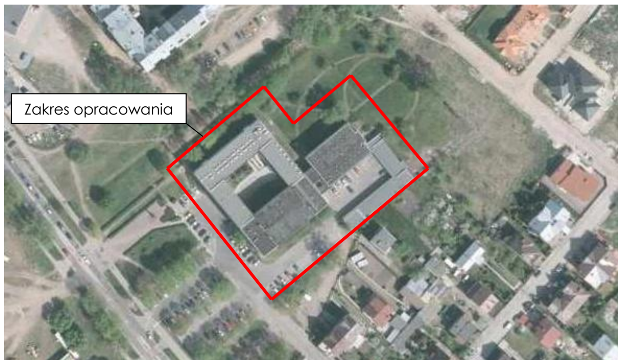
Widok budynku poddanego termomodernizacji
